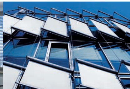
Sämtliche Jalousien in Abhängigkeit von Wind und Wetter zentral steuern
