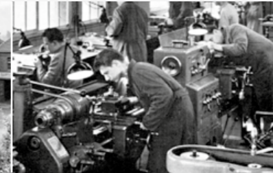
1940 Werkzeugbau in Schalksmühle
