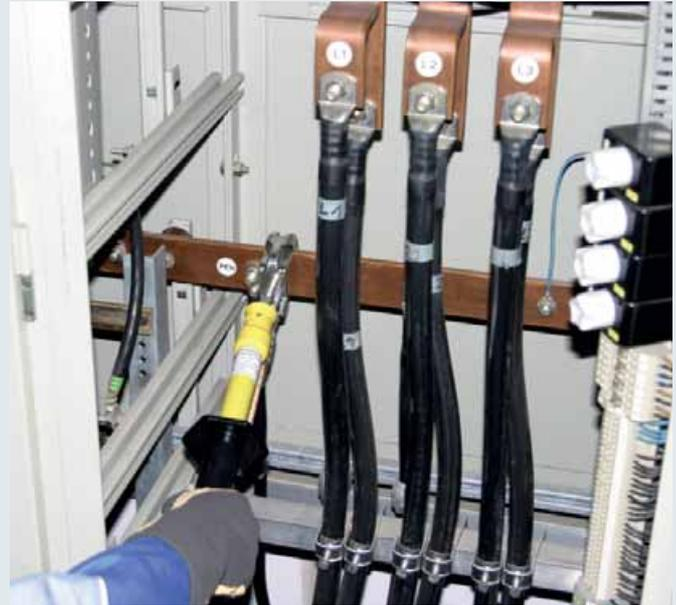
Einbringen einer Erdungs- und Kurzschlievorrichtung mit dem Erdungsgriff in einer Niederspannungsschaltanlage.
