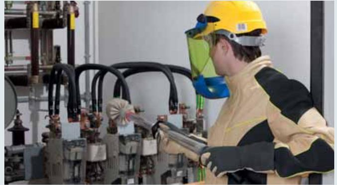
**Nachfüllen von Kabelendverschlüssen**
