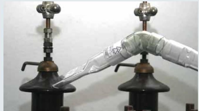
Reinigung eines Isolators mit einer Flachdüse und dem 135° Saugrohrwinkel.
