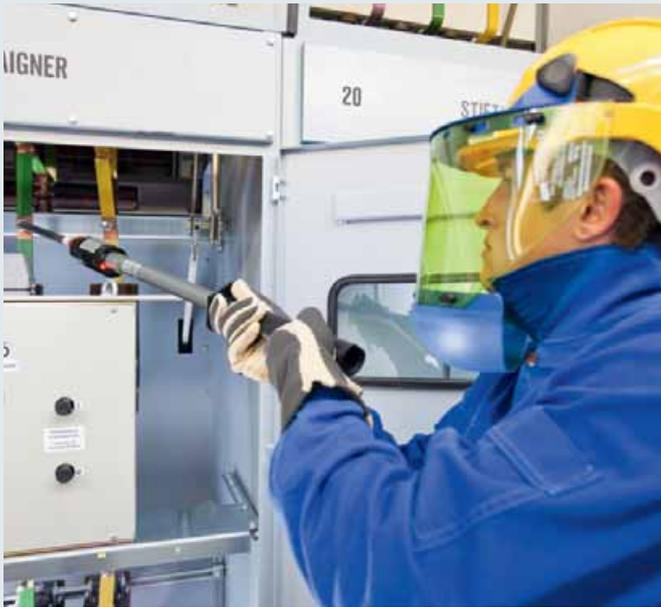
Spannungsprüfer PHE III mit optischer und akustischer Anzeige an einer Innenraumschaltanlage.
