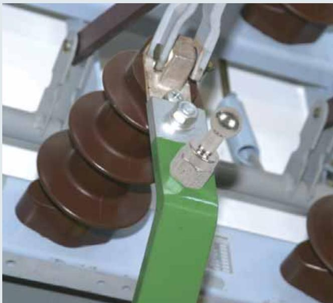
Kugelfestpunkt gerade, montiert auf einer Sammelschiene.
