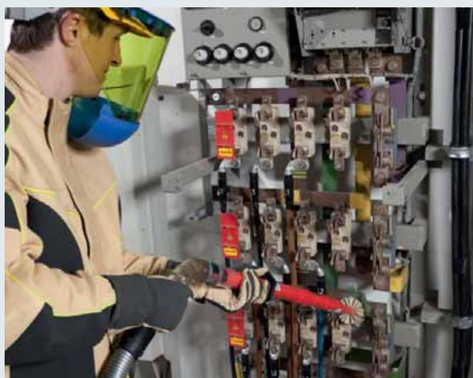
Reinigung eines NS-Schaltgerüsts
