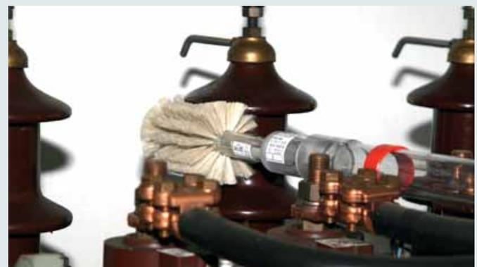
Reinigung eines Isolators mit einer Stabbürste.
