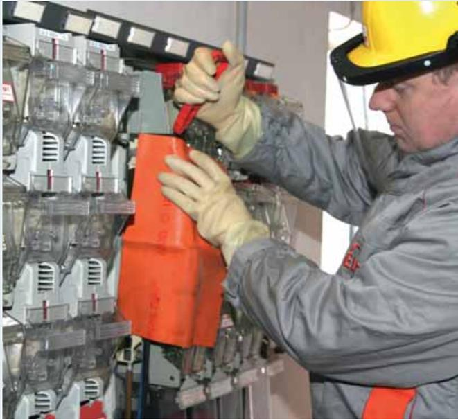
Arbeiten unter Spannung mit isolierenden Handschuhen bis 1000 V.
