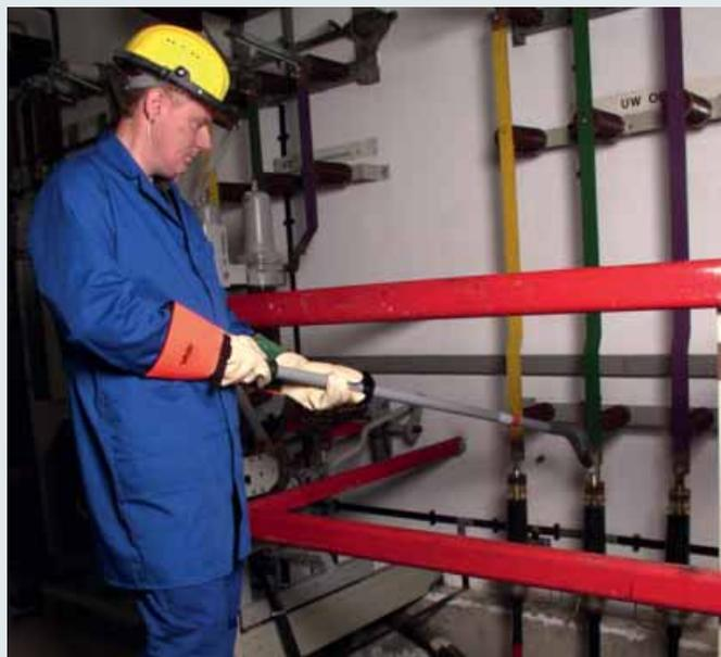
Öffnen der Verschlusschraube mit dem isolierenden Schraubendreher MS.
