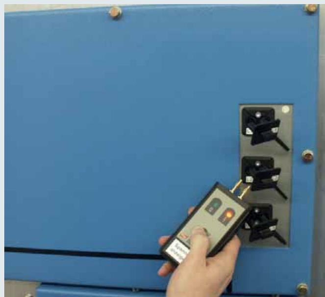
Eigenprüfung des Spannungsanzeigergerätes DEHNcap/A.
