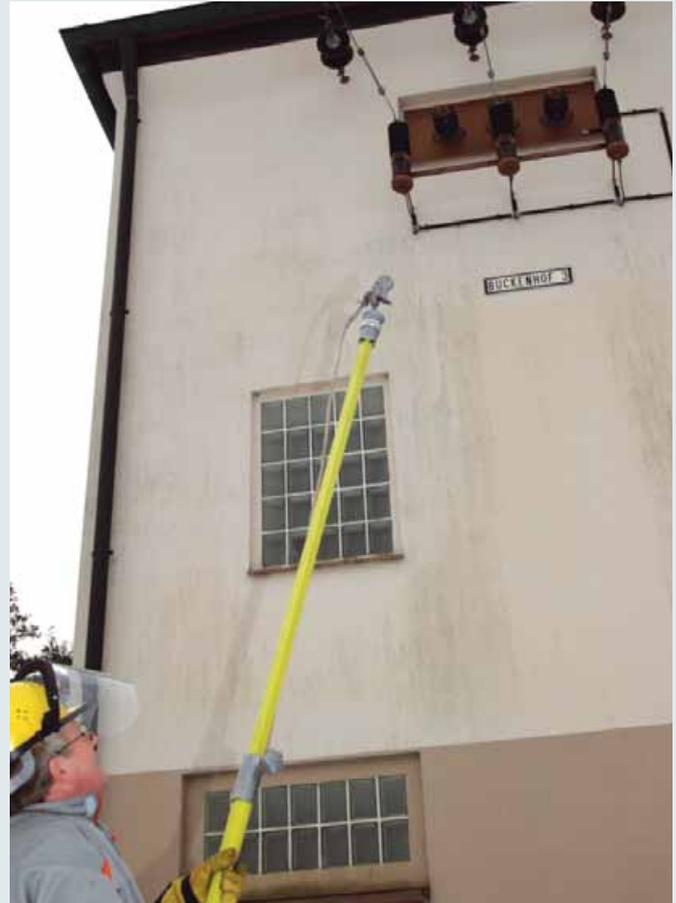
Teleskop-Erdungsstange mit Alu-Trichterkupplung und Phasenschraubklemme.
