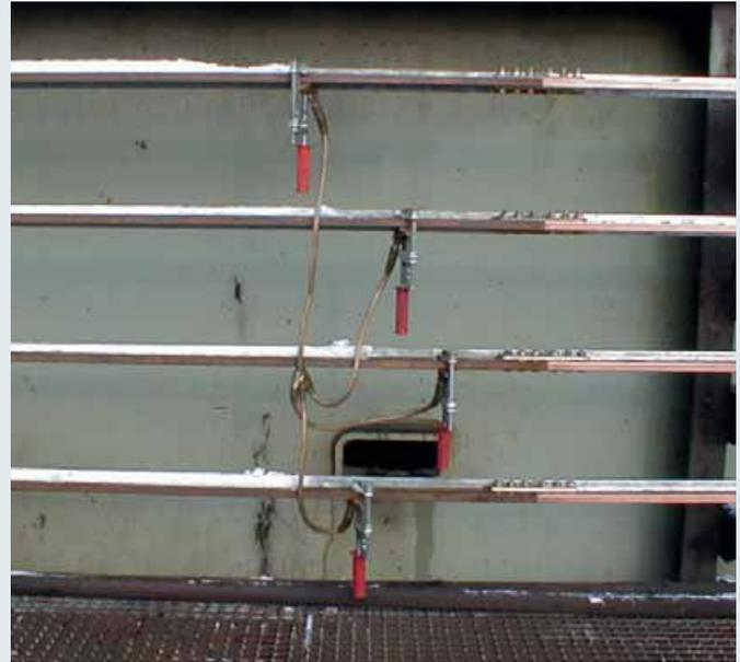
Dreipolige Erdungs- und KurzschlieÙvorrichtung mit Zwingenklemmen.
