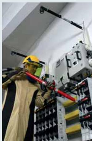
**Bild 3:** Arbeiten an offener Schaltanlage mit eingebautem mobilen Störlichtbogen-Schutzsystem
