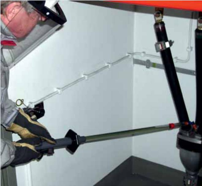
Nachfüllen erhitzter HT-Masse unter Spannung.
