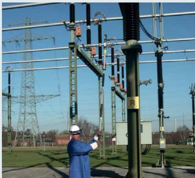
Abstands-Spannungsprüfer ASP in einer Freiluftschaltanlage.
