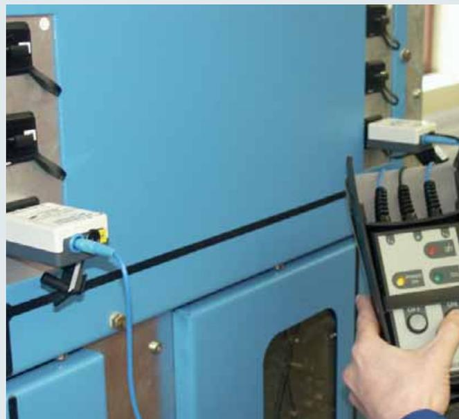
Einsatz des Phasenvergleichers DEHNcap/PC-LRM mit zwei HR-LRM Messadaptern an einer HR-Schaltanlage.
