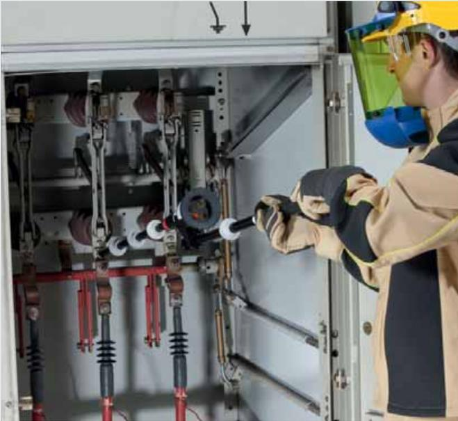
Einpoliger Phasenvergleicher PHV I an einer Schaltanlage.
