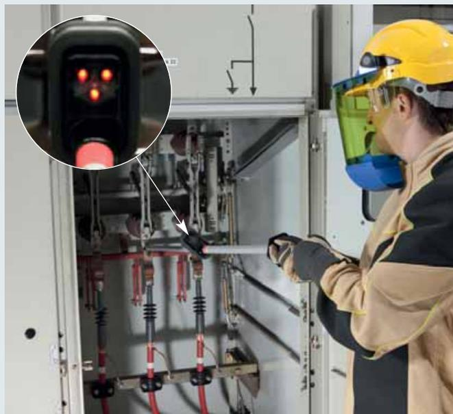
Spannungsprüfer PHG II an einer typgeprüften Schaltanlage.
