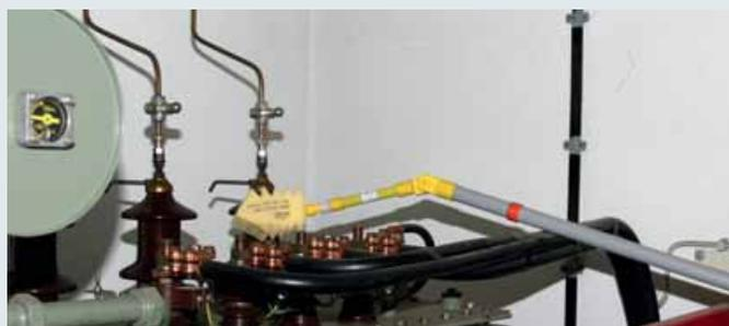
Trocken- und Feuchtreinigung eines Transformators mit dem Kombi-Reinigungsset TFRS MS unter Spannung.
