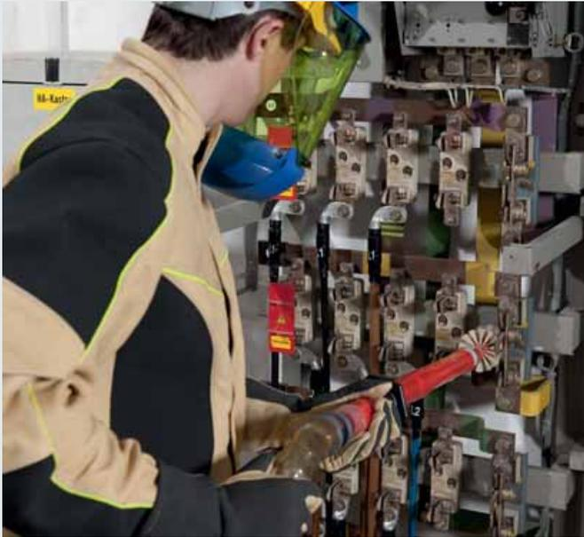
Reinigen mit dem Trockenreinigungsset TRS NS einer Niederspannungsschaltanlage unter Spannung.
