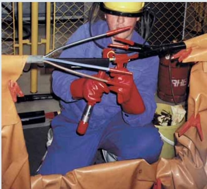
Abdecken von unter Spannung stehenden Teilen.
