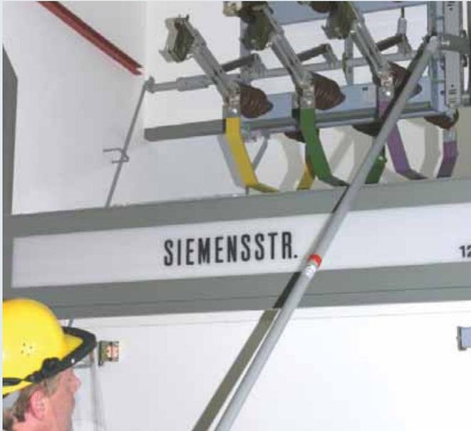
Betätigung eines Lasttrennschalters mit der Schaltstange SCS.
