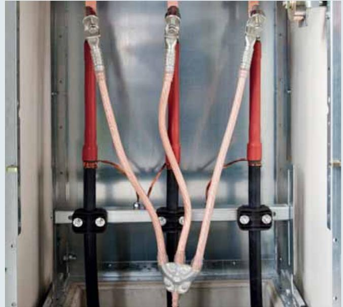
Bestückte dreipolige Erdungs- und KurzschlieÙvorrichtung in einer Schaltanlage.
