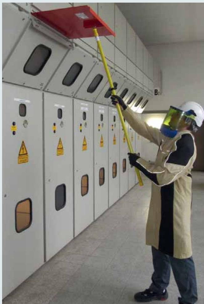
Einbringen einer Schutzplatte der Bauform A3 mit Arbeitsstange.
