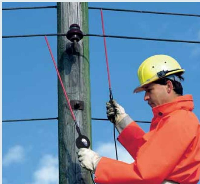
Zweipoliger Spannungsprüfer SPN mit Verlängerungsspitzen in der Freileitung.
