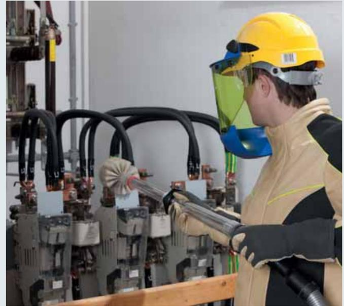
Reinigen eines Transformators mit dem Trockenreinigungsset TRS MS unter Spannung.
