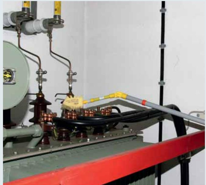
Feuchtreinigung eines Transformators mit dem Feuchtreinigungsset FRS ZK MS.
