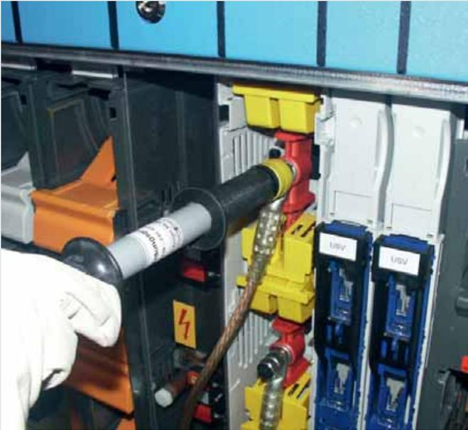
Einsetzen der teilisolierten Erdungs- und KurzschlieÙvorrichtung mit Hilfe des Erdungsgriffes TI.
