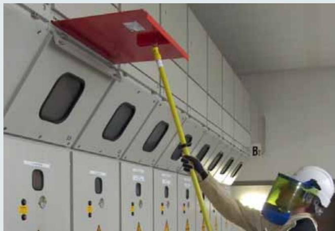
Einbringen einer Schutzplatte der Bauform A3 mit Arbeitsstange.
