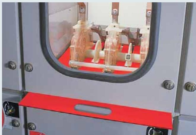
Einbringen einer isolierenden Schutzplatte der Bauform A4.
