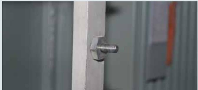
Erdanschlussstück zum Anschrauben mit Gewindebolzen M12 an ein geerdetes Anlagenteil.
