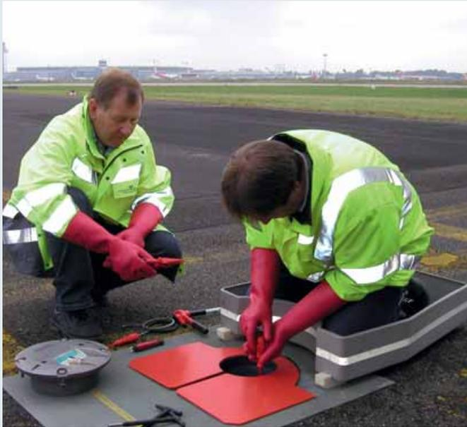
Austausch des defekten Leuchtmittels (Flughafenbefeuerung) auf der Start- und Landebahn.
