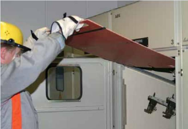
Einbringen einer isolierenden Schutzplatte der Bauform A1.
