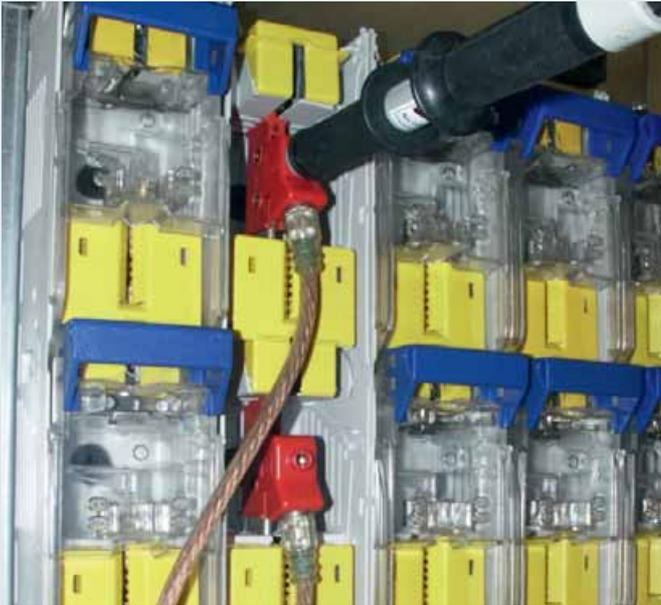
Einsetzen der vollisolierten Erdungs- und KurzschlieÙvorrichtung mit Hilfe des Erdungsgriffes VI.
