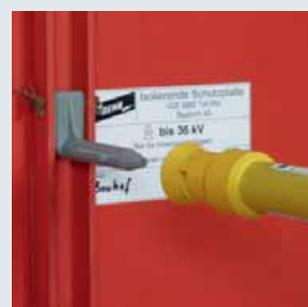
Arbeitsstange mit Spindel mit Querstift (Bajonett) und Kupplung Spindel mit Querstift an der isolierenden Schutzplatte.
