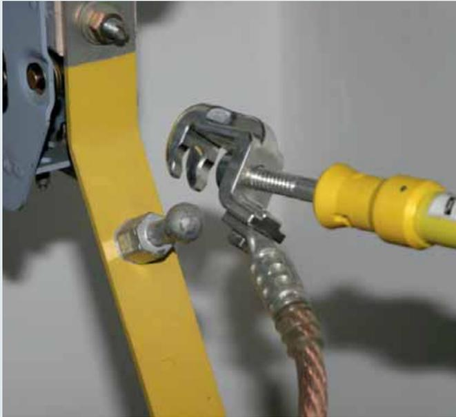
Phasenseitiger Anschluss der Universalklemme an einem Kugelfestpunkt.
