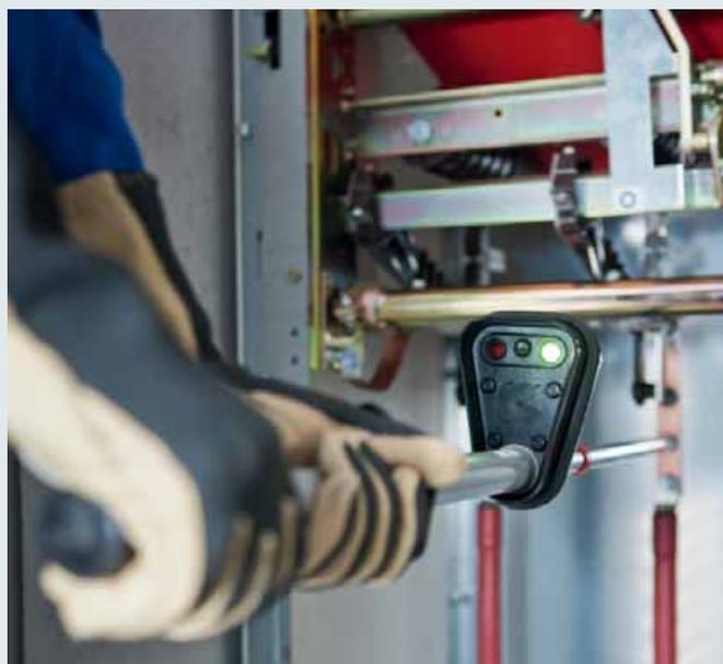
Spannungsprüfer PHE mit optischer Anzeige.
