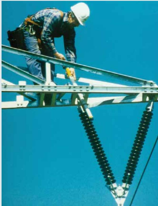
Abstands-Spannungsprüfer an einer 110 kV-Freileitung.
