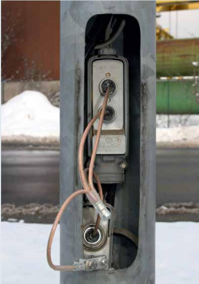
Erdungs- und KurzschlieÙvorrichtung an einem Übergangs- und Sicherungskasten eines Straßenbeleuchtungsmastes.
