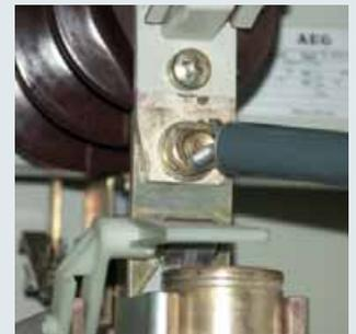
Prüfung mit aufgeschraubter V-Elektrode.
