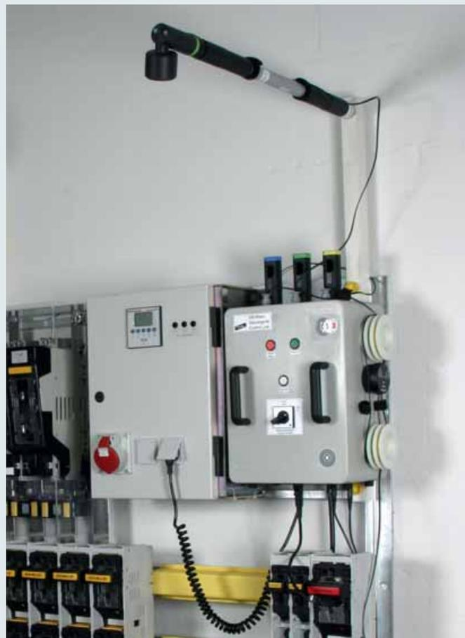
Lichtsensormontage mit am Schaltgerüst installierter Lichtsensorhalteschiene.
