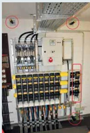
**Bild 2:** Fest eingebaute Komponenten zur Aufnahme des mobilen Störlichtbogen-Schutzsystems
