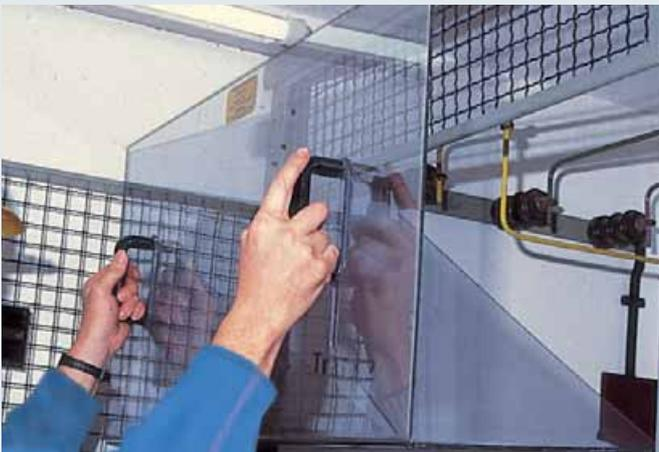
Einbringen einer isolierenden Schutzplatte (in durchsichtiger Ausführung) der Bauform A2.
