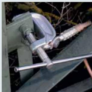
Erdungsfräsklemme an lackiertem Stahlmast.
