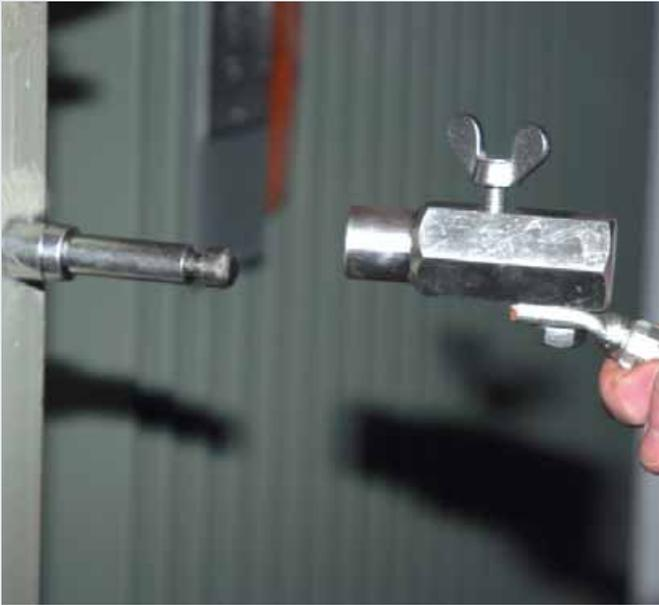
Erdungsfestpunkt mit Ringnut und Erdanschlussbuchse.
