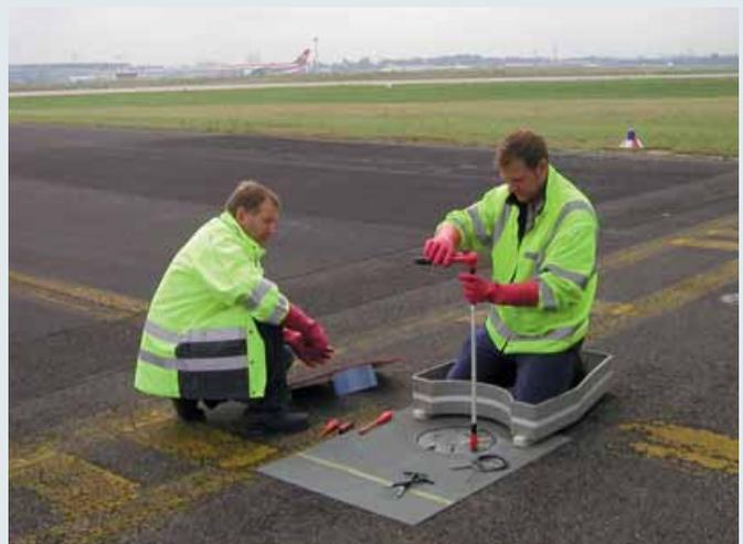
Die isolierende Verlängerung wird beim Aufschrauben der Leuchte als isoliertes Zwischenteil verwendet.
