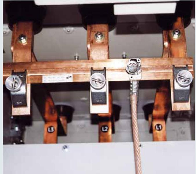
Kurzschliefschiene mit Erdungsseil an einer Schaltanlage.
