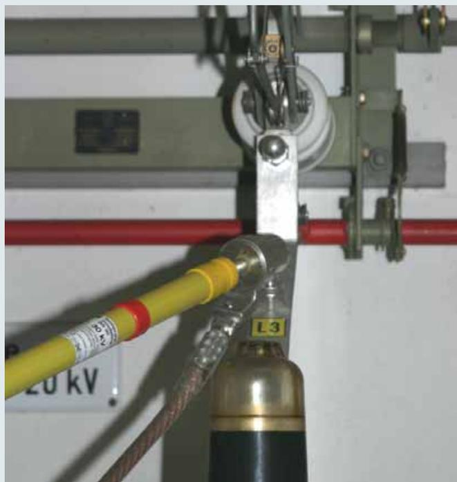
Isolierstange IS SK zur Betätigung von Klemmen mit Spindel mit Sechskant von Erdungs- und Kurzschließvorrichtungen.
