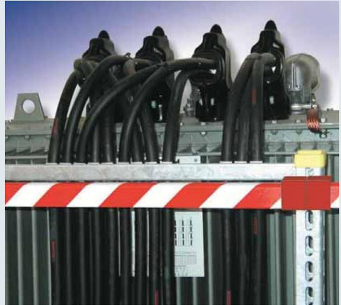
Absperrbalken montiert in Trafostation.
