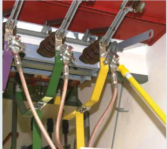
Einbringen einer Erdungs- und KurzschlieÙvorrichtung mit einer Erdungsstange.
