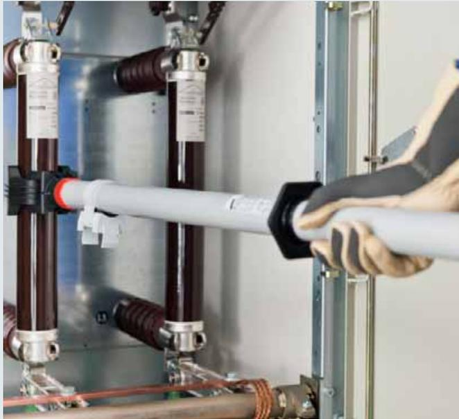
Sicherungsstange SZ zum Einsetzen und Herausnehmen von HH-Sicherungen.
