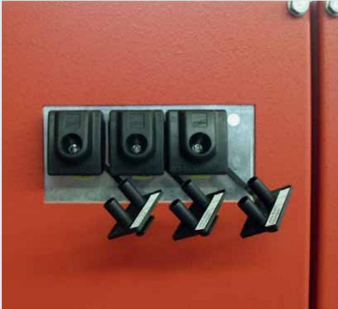
Passives Spannungsanzeigergerät DEHNcap/P an einer gekapselten Schaltanlage.
