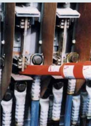
Anwendung abgeschrägte Flachdüse.
