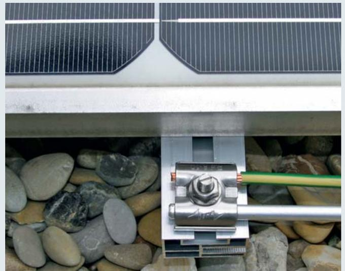
mit Hammerkopfschraube M10 und Sperrzahnmutter
