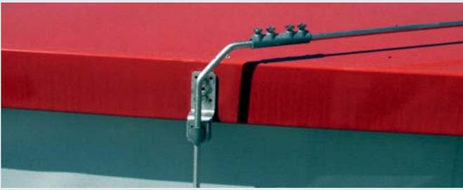
Verbindungsmuffen für den Zusammenschluss von zwei Rundleitern in Längsanordnung mit vier Schrauben M6
