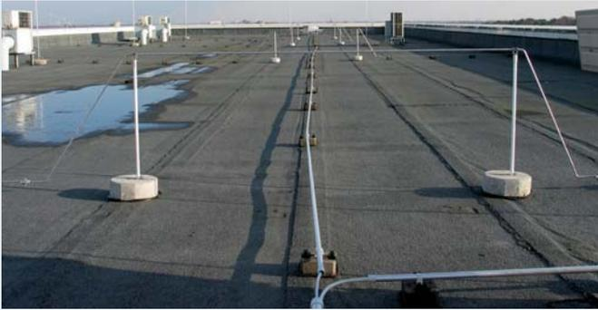
Aufgeständerte Fangeinrichtung mit Distanzhalter und Betonsockel im Bereich der Elektroinstallation auf dem Dach
