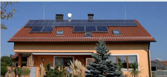
Getrennte Fanganlage – alle Dachaufbauten wie Solarthermie-, PV- und Abgasanlage inkl. Parabolantenne im Schutzbereich
