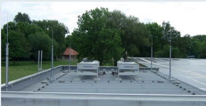
Die HVI-light-Leitung ermöglicht auch Installationen, ohne dass am Ende eines Anpassungsbereiches eine Verbindung zum Potentialausgleich der baulichen Anlage hergestellt wird.
