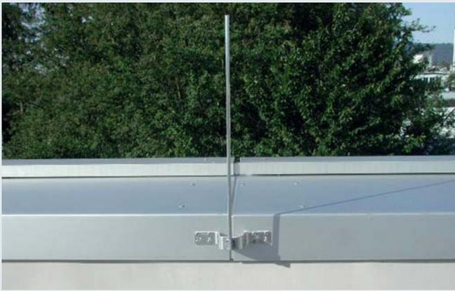
Überbrückungslaschen zum Anschließen und Verbinden von Metallverkleidungen, zum Nieten oder Schrauben
