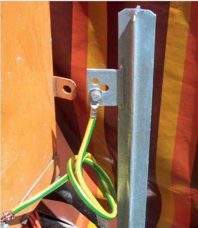
Profilstaberder zum Errichten von Erdungsanlagen z. B. für Antennen- oder Baustromverteiler-Erdungen
