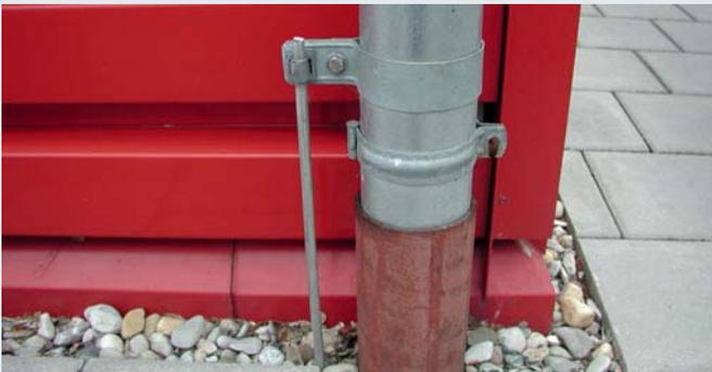
Rohrschellen zum Anschluss von Regenfallrohren an den Blitzschutz-Potentialausgleich nach DIN EN 62305-3 (VDE 0185-305-3)
