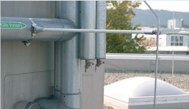
Distanzhalter mit Aufsatz, Befestigungsbuchse und Spannband
