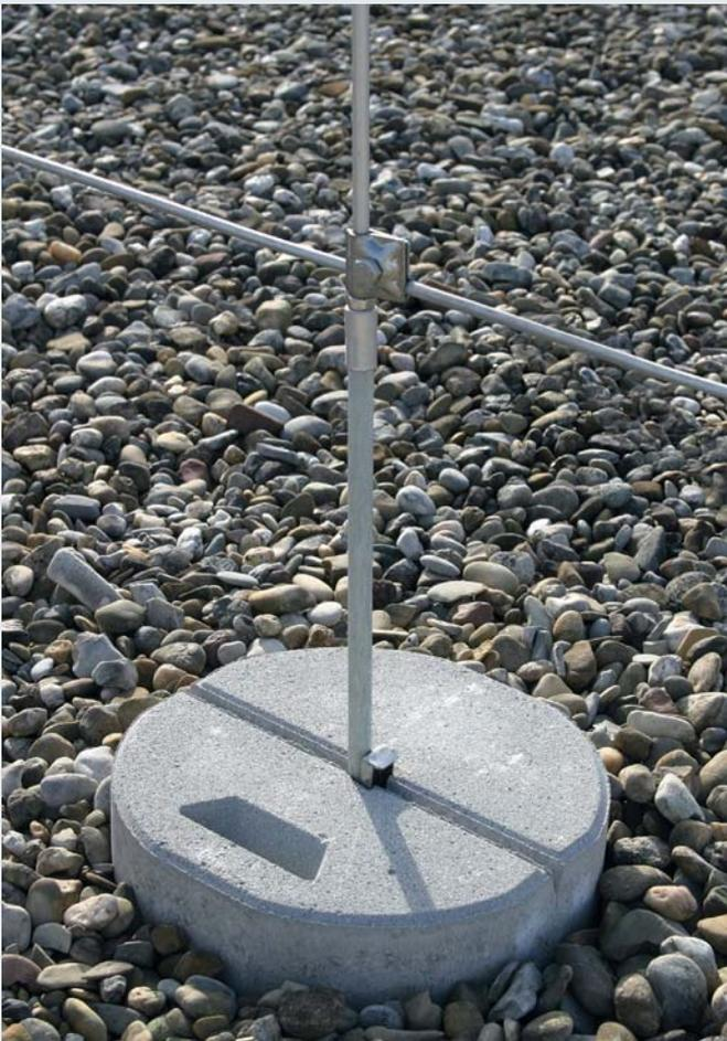
Fangstange zum Aufbau von Getrennten Fangeinrichtungen z. B. auf Flachdächern, errichtet im Betonsockel mit Keiltechnik
