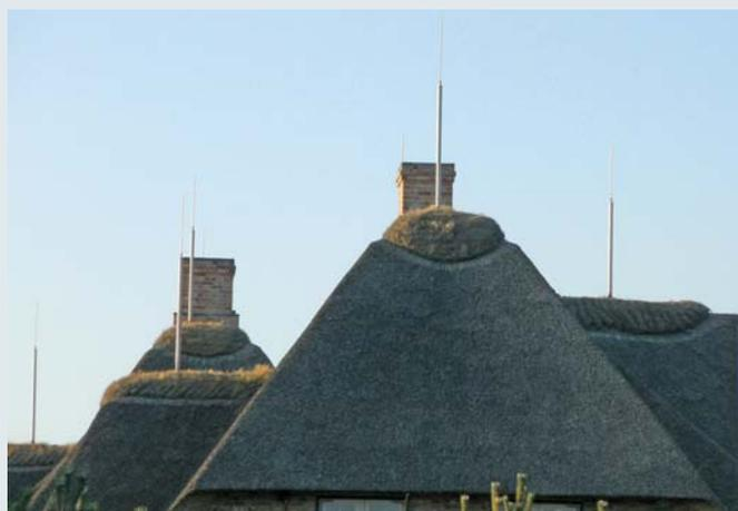
**Bild 4:** Neue Ausführung – Blitzschutz für Weichdächer (Ausschnitt)
