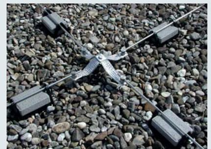
Hinweis: An Kreuzungspunkten können zwei Überbrückungsbänder mit einer Schraube M10x20 mm und Mutter verbunden werden.
