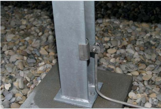
Anschlussklemmen, schwere Ausführung, für den Anschluss an Stahlkonstruktionen
