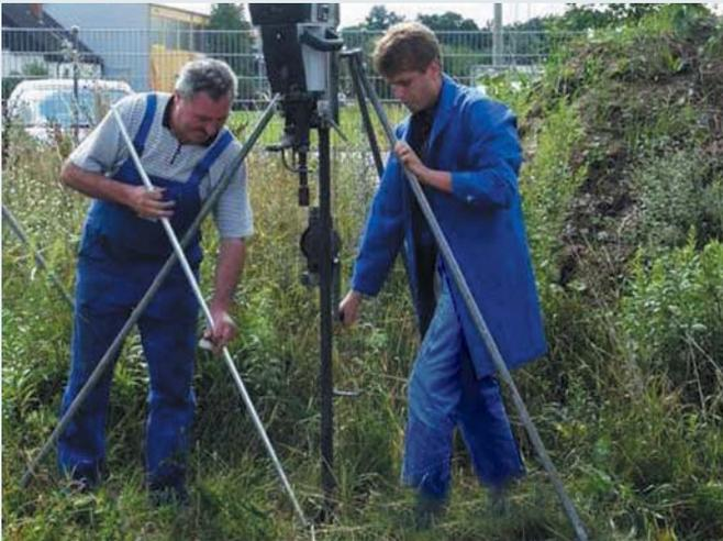
Hammergerüst zum Eintreiben von Tiefenerderstäben der Länge 1000 und 1500 mm mit Vibrationshämmern
