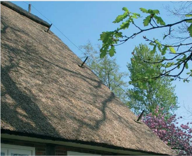
Die Fangleitungen auf Dächern aus Reet, Stroh oder Schilf müssen frei gespannt verlegt werden z. B. auf isolierenden Stützen. Auch im Bereich der Traufe sind bestimmte Abstände einzuhalten.
