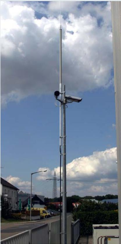
Optisch angepasste innenliegende Verlegung der HVI-Leitung im Stützrohr mit geringer Windangriffsfläche.
