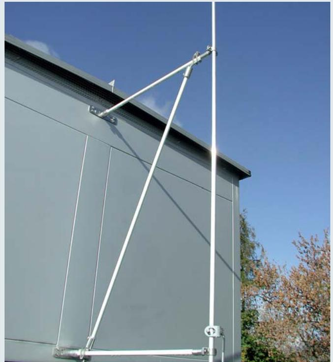
Variables Halterprogramm für Leitungen und Fangstangen zur Einhaltung des Trennungsabstandes nach DIN EN 62305-3 (VDE 0185-305-3)
