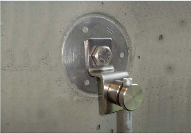
Endstücke zum Anschrauben an Erdungsfestpunkt (EFP) für den Anschluss z. B. einer Potentialausgleichsschiene oder zum Anschließen von Konstruktionsteilen (z. B. Stahlträger oder dgl.) durch Anschrauben
