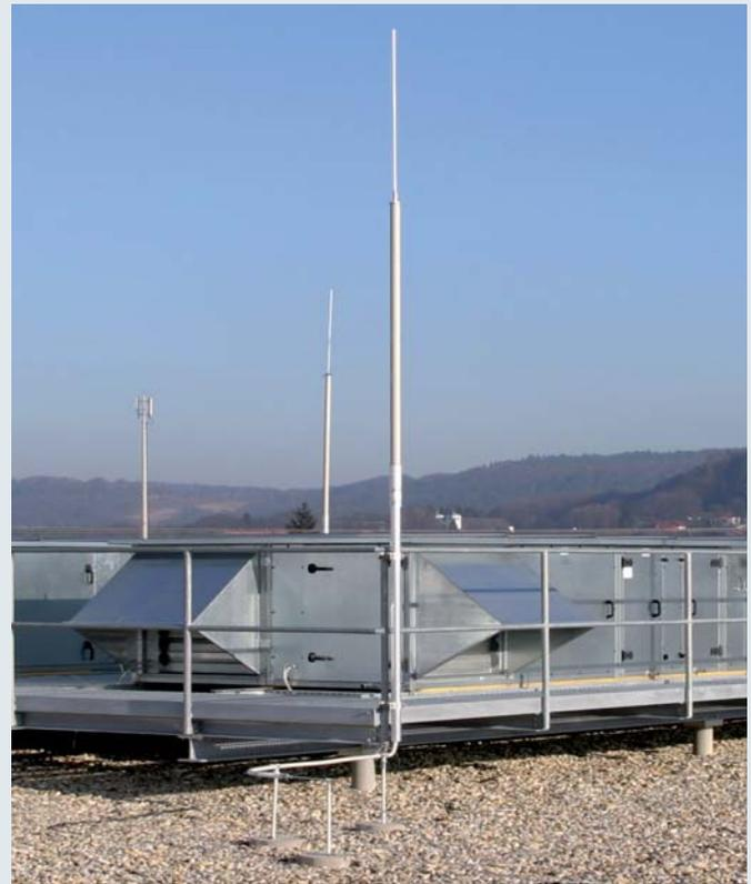
Getrennte Fangeinrichtung für Rückkühlanlage mit HVI-Leitung grau im Stützrohr
