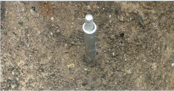
Tiefenerder zum Errichten von Erdungsanlagen für Ableitungen oder Trafostationen
