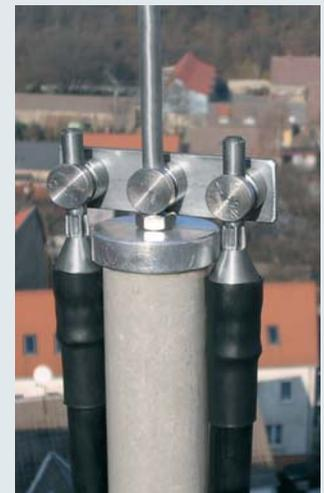
HVI-Leitung – parallel geführt mit Anschlussklemme Art.-Nr. 301 329
