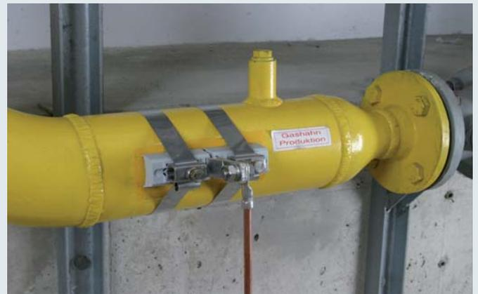
Bandrohrschelle zur elektrischen Kontaktierung von Rohren im Ex-Bereich, zur Umsetzung des Blitzschutz-Potentialausgleichs nach DIN EN 62305-3 (VDE 0185-305-3)
