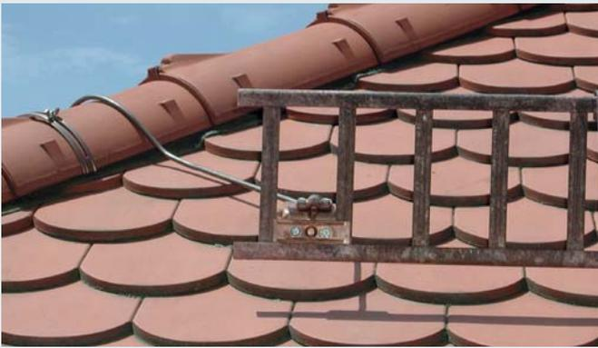
Klemmen zum Verbinden von Leitungen mit Schneefanggittern, Anschluss mit Zweischrauben-Überleger, längs
