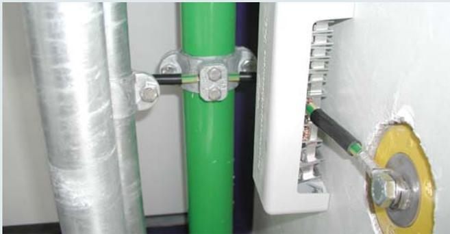
Potentialausgleichsschienen für den Schutz- und Funktionspotentialausgleich nach DIN VDE 0100 Teil 410/540 und den Blitzschutz-Potentialausgleich nach DIN EN 62305-3 (VDE 0185-305-3)
