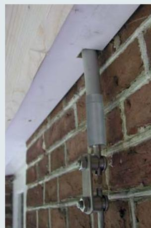
**Bild 3:** Anschluss an Ableitung – Durchführung Gesimsbrett
