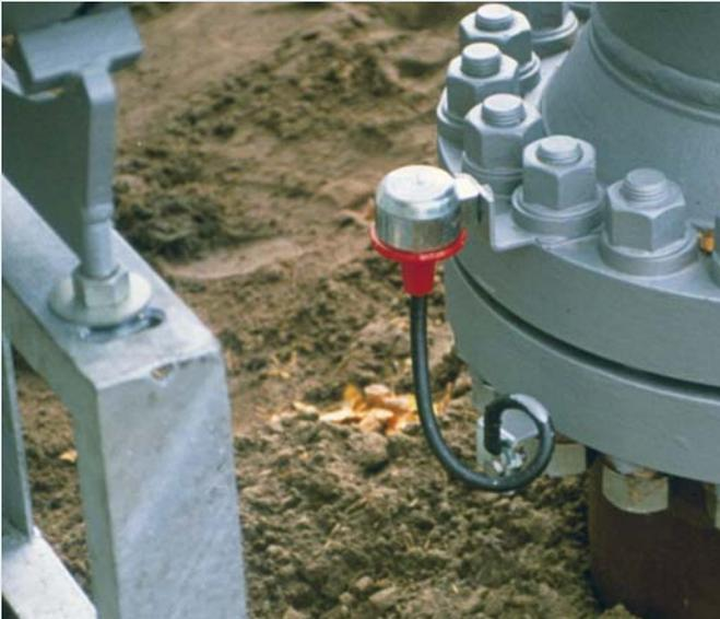
ATEX- und IECEx-zertifizierte Trennfunkstrecke für den Blitzschutz-Potentialausgleich nach DIN EN 62305 / VDE 0185 in bewährter Ausführung mit flexiblem Leiteranschluss
