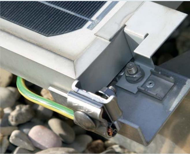
Falzklemme zum Einbinden der Montagesysteme z. B. von PV-Anlagen in den Funktionspotentialausgleich/Funktionserdung (Leiterfarbe ggf. schwarz) und Blitzschutz-Potentialausgleich nach DIN EN 62305-3 (VDE 0185-305-3)
