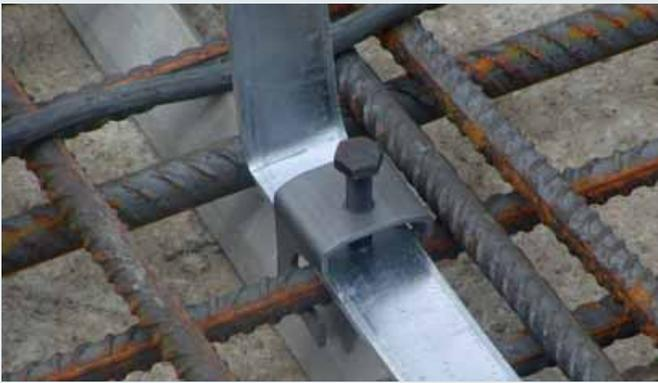
Klemmen zum Verbinden von Betonstahlmatten oder Bewehrungen mit Rund- und Flachleitern
