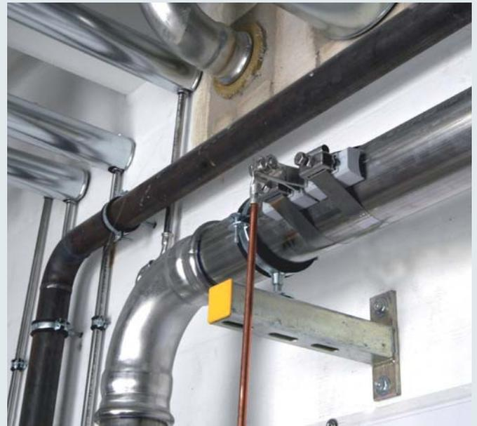
Anwendung an einem NIRO-Rohr
