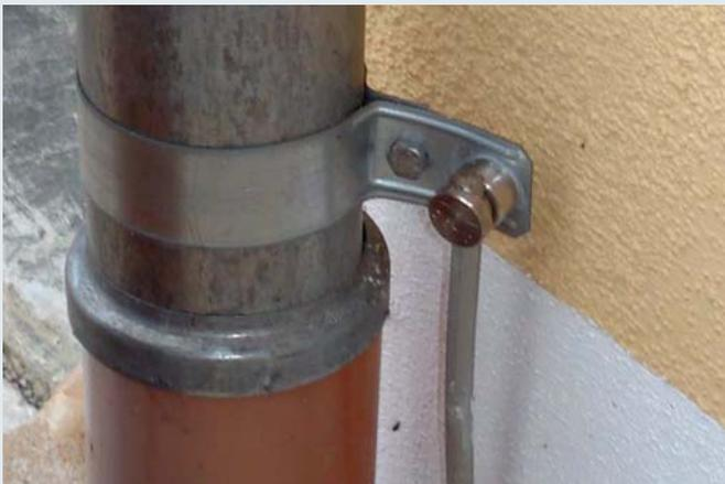
Klemmschrauben-Verbinder zum blitzstromtragfähigem Anschluss von Rundleitern z. B. an Flachprofile, Regenrohrschellen oder andere Teile der Blitzschutzanlage
