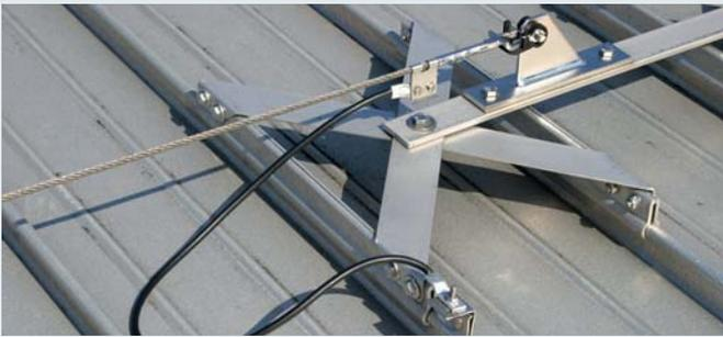
System zum Verbinden von Seilsicherungssystemen auf Dächern an die vorhandene Fangeinrichtung; mit montierter Anschlusslasche für Sicherungsseil ( $\varnothing 6$  mm oder  $\varnothing 8$  mm) und Klemmbock (Rd 6-10 mm)
