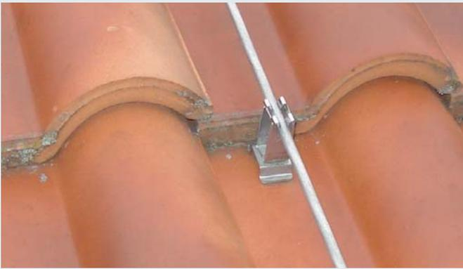
Dachleitungshalter zum Einhängen in den Dachziegel mit flexibler Grundstrebe aus dünnem NIRO (0,3 mm), zum Anformen an die Falze der Dachziegel/Dachsteine
