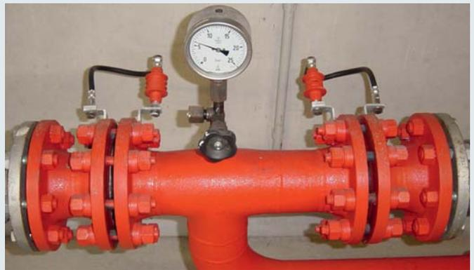
den Anschluss der Funkenstrecke an Rohrleitungsflanschen. Die Ausführungsvariante EXFS 100 KU ist von einem feuchtigkeitsdichten Kunststoffmantel umgeben und somit ideal für den unterirdischen Einsatz an Isolierkupplungen geeignet.
