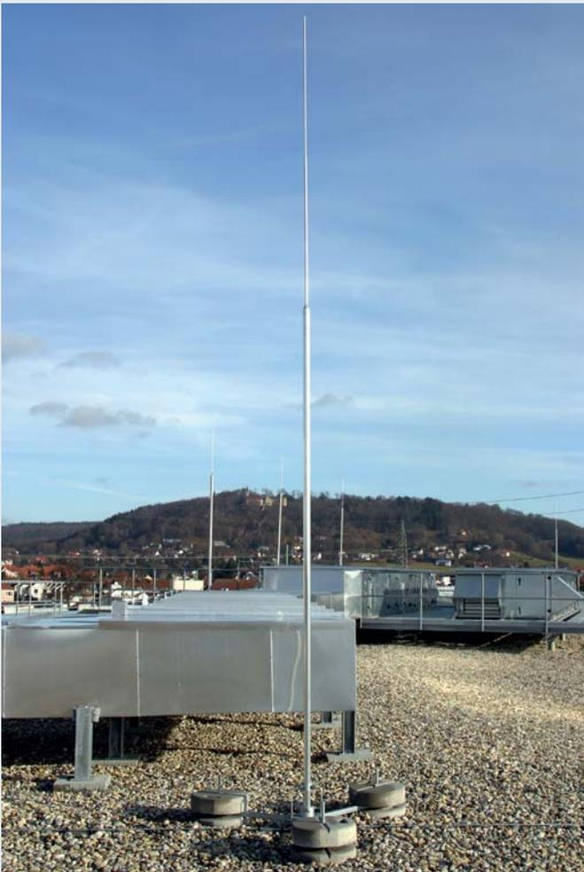
Fangstange freistehend mit klappbarem Dreibeinstativ zum Schutz von größeren Dachaufbauten und Anpassung an die Dachneigung bis max. 10°. Die Fangstangen sind für eine Windgeschwindigkeit bis 145 km/h (Windlastzone II) dimensioniert.
