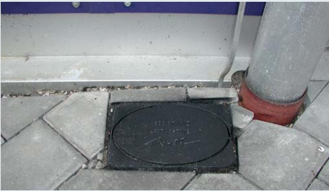
Trennstellenkästen für Unterflurmontage, zum Trennen der Ableitung von der Erdungsanlage beim Messen
