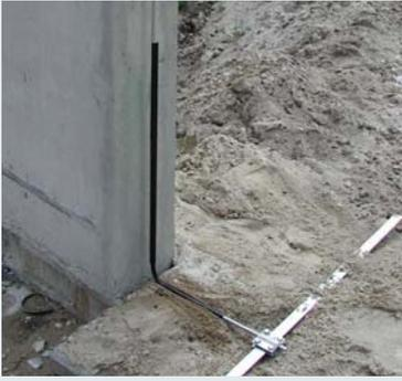
Erd Einführungsstangen für den Anschluss der Ableitungen an die Erdungsanlage
