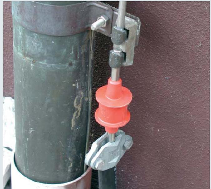
Für den Blitzschutz-Potentialausgleich nach DIN EN 62305 / VDE 0185 sowie zum Einsatz in informationstechnischen Anlagen nach DIN VDE 0845.
