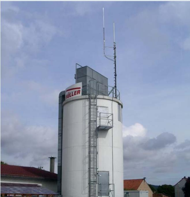
Für verschiedene funktechnische Anwendungen werden Antennen eingesetzt, die eine 360°-Abstrahlcharakteristik besitzen. Derartige Rundstrahl-Antennen sind auch unter dem englischen Begriff "Omni-directional Antennas" (Omni-Antennen) im Markt bekannt. Typische Anwendungen für Omni-Antennen in der Praxis sind: Betriebsfunk, Sicherheitsnetze und vereinzelt auch GSM-Netze. Die Anwendung in GSM-Netzen erfolgt nur dann, wenn eine geringe Funkbelastung/Funkhäufigkeit vorhanden ist.
