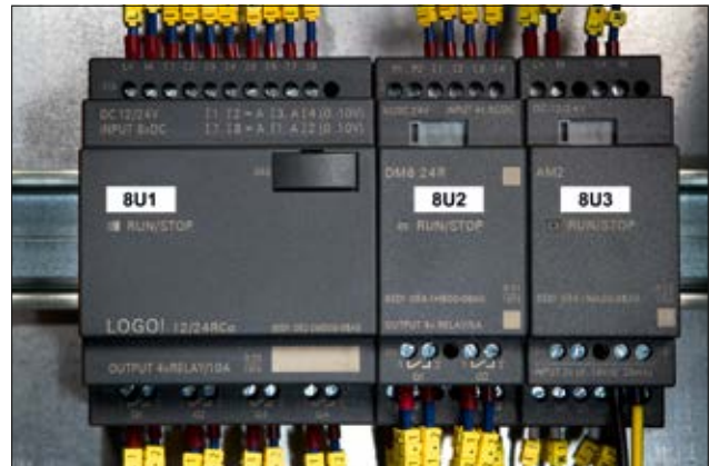
Helatag Laseretiketten ermöglichen die einfache und schnelle Kennzeichnung von Schaltschränken.
