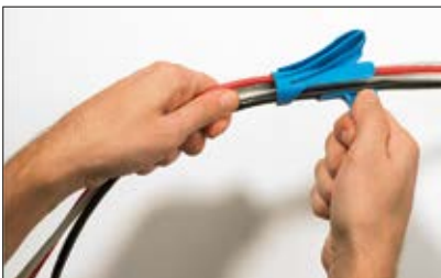
Kabelbündel seitlich in das Aufziehwerkzeug legen.
