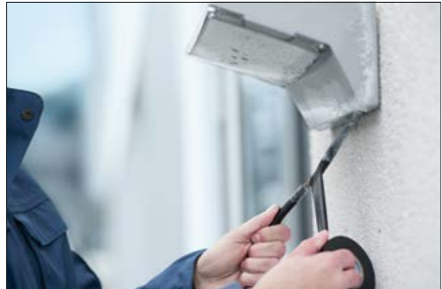
Das Premiumisolierband HelaTape Flex 1000+ lässt sich sehr gut bei niedrigen Temperaturen verarbeiten.
