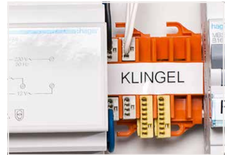
Anwendung für eine Hausklingelanlage – Befestigung auf Tragschiene 35
