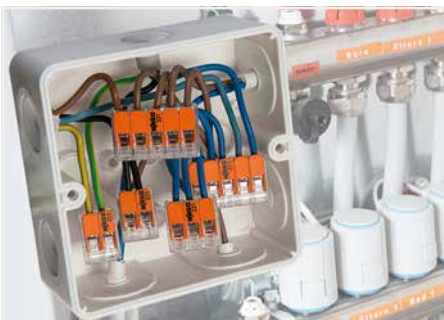
Verdrahtung feindrätiger Leiter in Installationsdosen bei Fußbodenheizung
