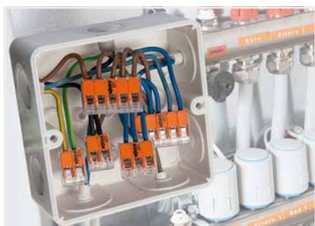
Verdrahtung feindrätiger Leiter in Installationsdosen bei Fußbodenheizung
