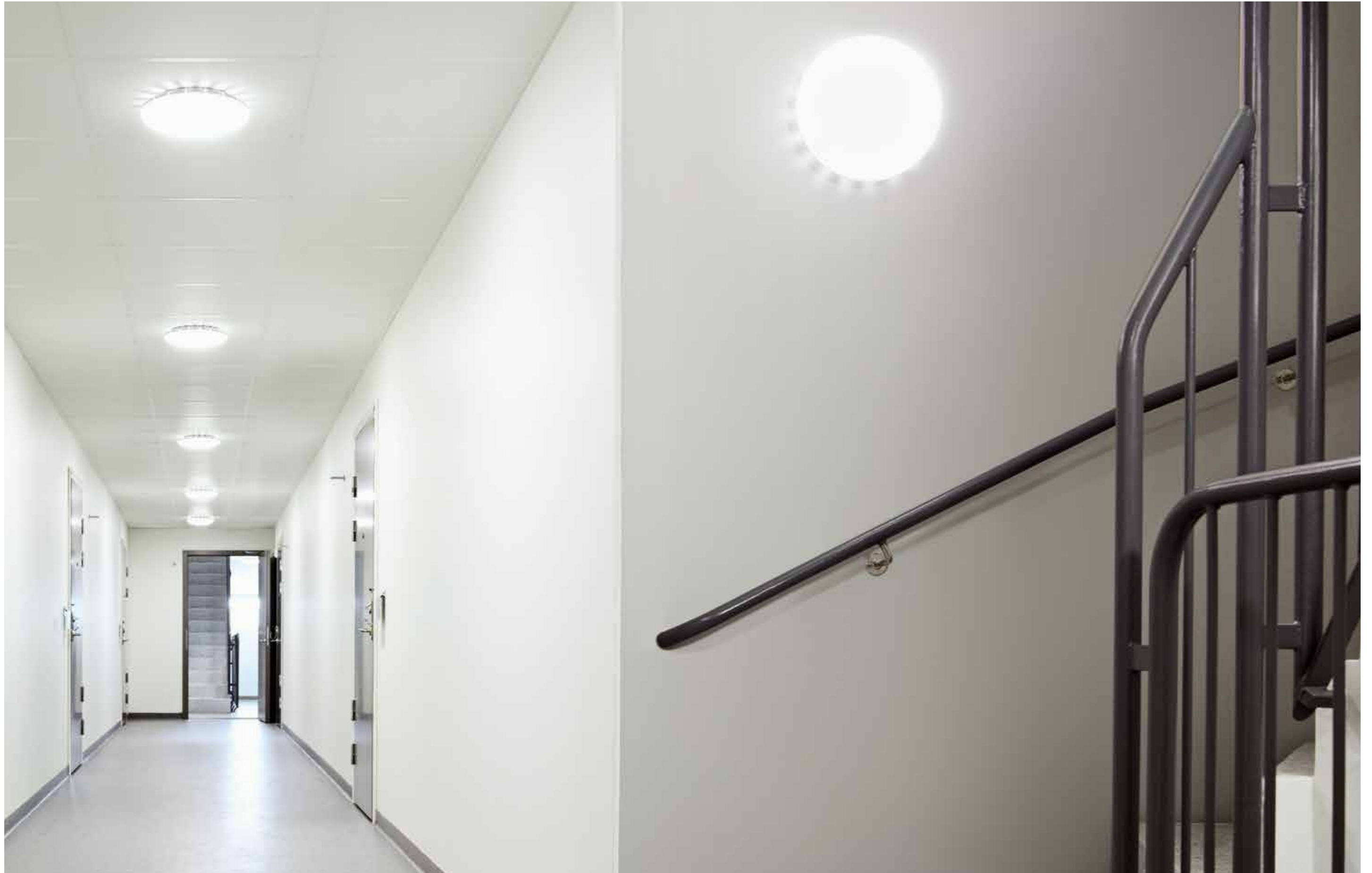
Die Hochfrequenz-Sensorleuchte RS PRO LED S1 In den Treppenhäusern und Fluren der IKANO-Wohnanlage Helsingborg, Schweden.
