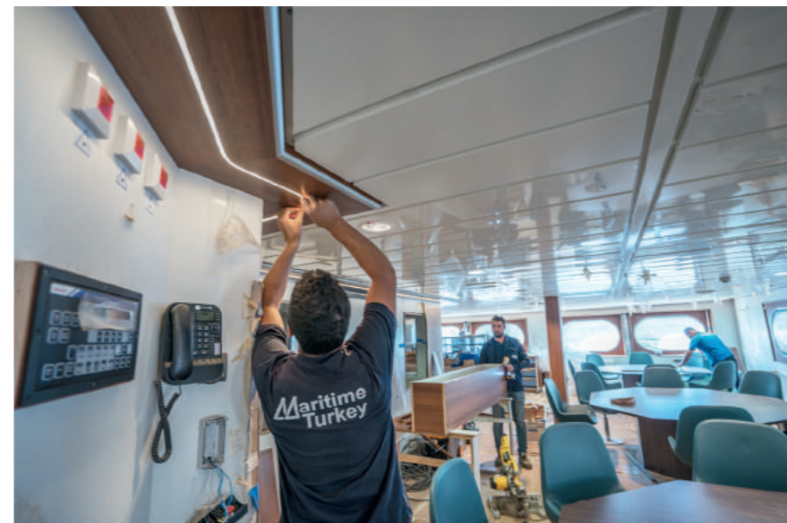
AL 45 LED-Streifen von Glamox werden am arktischen Frosttrawler Northern Osprey II vor dessen Überführung ins kanadische Halifax angebracht.
