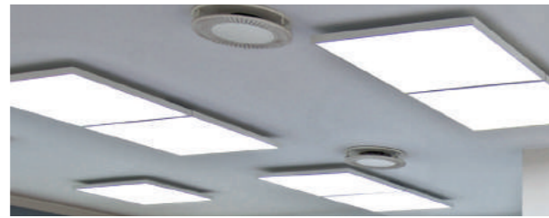
Das Licht in den Therapieziimmern wird durch deckenmontierte Glamox C95-S Leuchten mit dimmbaren weißen LED-Lichtquellen und einer blendungsfreien mikroprismatischen Optik geliefert.
