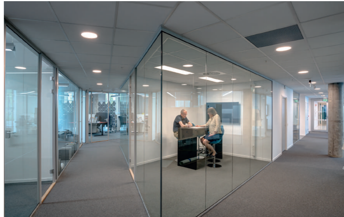
Flexibilität ist ein Schlüsselwort bei der Gestaltung des Abels hus. Die Stockwerke sind in technische Module in einem 2,40 Meter messenden Gitter unterteilt. In jeder Gittereinheit können Beleuchtung, Heizung und Lüftungsanlage getrennt gesteuert werden. Jede Einheit wird höchstens von vier Personen geteilt. Auf diese Weise kann die Anordnung von Bürozellen in eine Landschaft und umgekehrt verändert werden.
