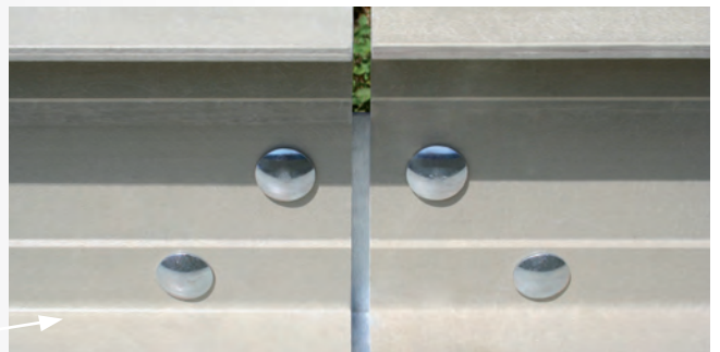
Flachrundkopfschrauben, eingehaltener Ausdehnungsspalt
