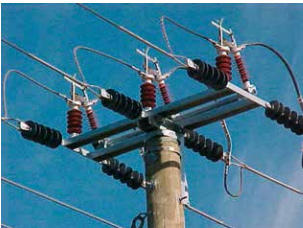
Leitungstützisolator in Verbundbauweise
