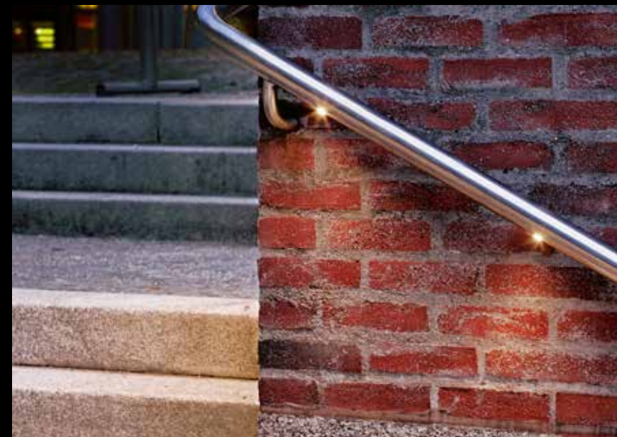
Projekt / Project: Gasteig München, Deutschland / Munich, Germany Planer / Lighting Design: Ulrike Brandt Licht, München / Munich Fotografie / Photography: Hustedt network, Hamburg
