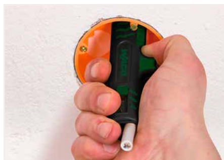
Abmanteln des Kabelmantels
