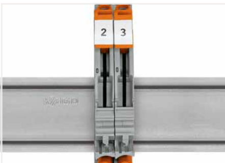
Kurzschluss für Stromwandler-Prüfschaltungen vorbereiten.
