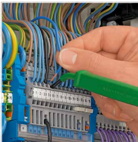
Öffnen der Klemmstelle mit Betätigungswerkzeug
