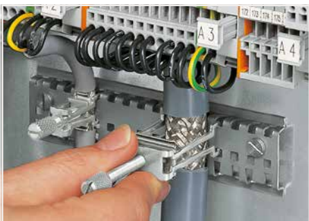
Aufstecken eines weiteren Schirmklemmbügel
