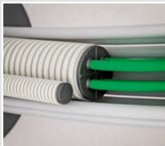
Rohrenden rauchdicht verschließen (z.B. mit KAISER Dichtstopfen).
