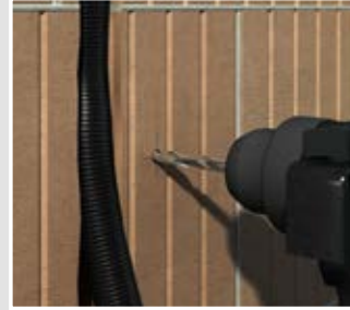
Ein Loch mit \varnothing 8 mm und Tiefe = Überlänge Dübel + 10 mm bohren.
