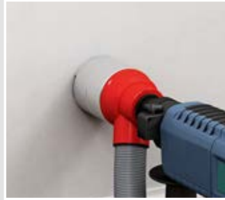
Bei Dämmstärken < 100 mm Wandöffnung erstellen (Ø 82 mm)
