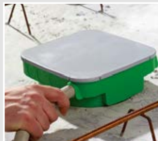
Rohre einführen und fertig betonieren.
