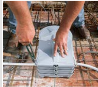
Gehäuse zusätzlich an der Bewehrung sichern.
