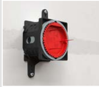
Leitung abmanteln, Signaldeckel einsetzen
