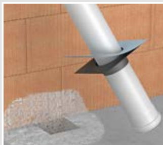
Manschette über Leitung/Rohr ziehen und die Schutzfolie abziehen.
