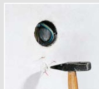
Die genaue Position der Gerätedose zeigen nach dem Verputzen die feinen Markierborsten des Signaldeckels an.
