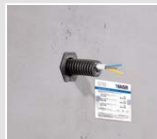
Wanddurchführung durch Brandschutzwand aus Beton.
