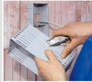
Aufstockelement ggf. an die Dämmstärke anpassen.
