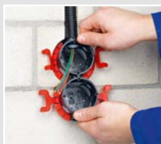
Dose mit aufgerastetem KLEMMFIX® einsetzen.
