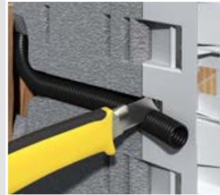
Das Rohr in die seitliche Führung drücken und ablängen.
