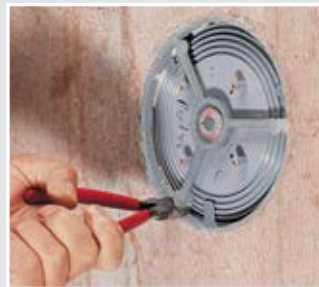
Nach dem Entschalen: Stege entfernen und Frontteil öffnen.
