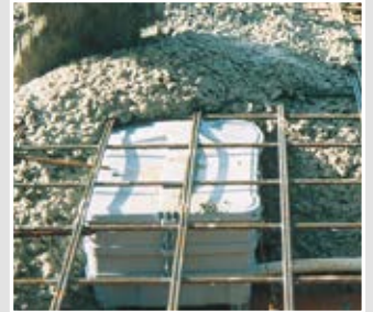
Sicherer und fester Sitz der Gehäuse beim Betonieren.
