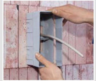
Aufstockelement aufsetzen und einrasten.
