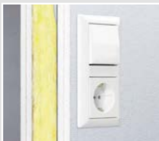
Einbaubeispiel mit einer Schalter-Steckdosenkombination.
