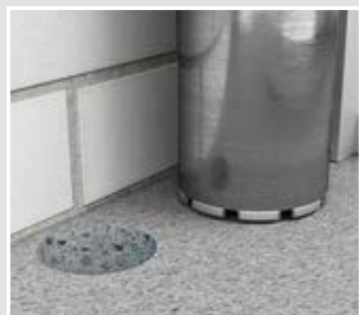
Erstellung einer Kernlochbohrung 150 mm oder 100 mm.
