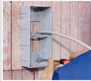
Gehäusebasis auf der Wand festschrauben.
