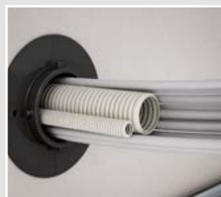
Mantelleitungen und Rohre durch den Schottzylinder führen.
