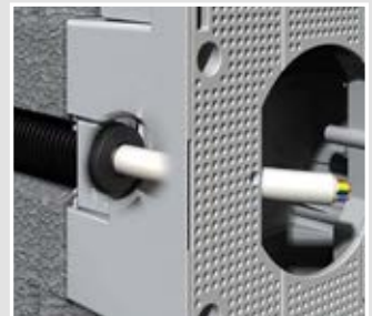
und das Rohr mit einem Dichtstopfen versehen.
