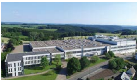
Hauptsitz KAISER Schalksmühle, Deutschland
