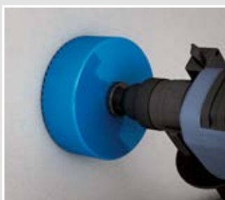
Installationsöffnung mit einem Fräser \varnothing 120 mm (z.B. Bi-Metall Fräser 1082-20) erstellen.
