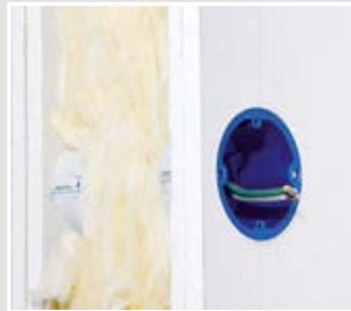
Gegenüberliegender Einsatz der Schallschutzdose.
