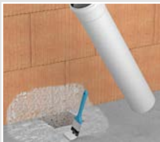
Mineralische Untergründe und Holzfasertplatten mit Haftprimer vorbehandeln.
