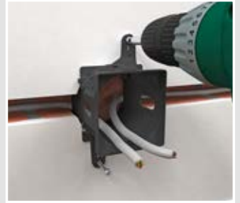
Leitung rückseitig in Adapter einführen, Adapter an der Wand befestigen
