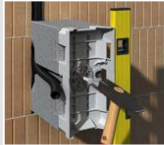
Geräteträger an die Wand halten, ausrichten und mit Dübel befestigen.
