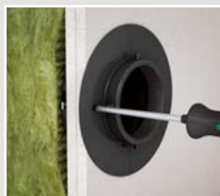
Schottzylinder, wie bei Hohlwanddosen, durch das Anziehen der Laschenschrauben befestigen.
