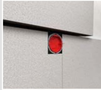
Anbringen der Innendämmung um die Dose herum
