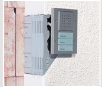
Nach Aufbringen der Putzschicht das gewünschte Gerät einsetzen.
