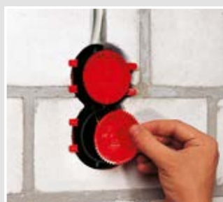
Signaldeckel aufsetzen.
