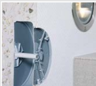
Gehäuse mit Einbausatz vormontieren.
