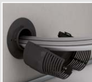
Dichtelement aufklappen und entfernen.
