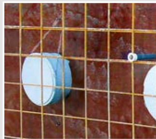
Befestigung an der Schalung mit Spanndraht und Nägeln.
