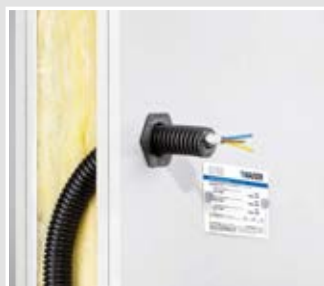
Wand Einführung M16 – M25 in Trockenbau-Brandschutzwand mit M25 Rohr.
