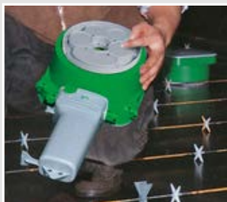
HaloX®-P-Gehäuse mit Montageplatte auf dem Schaltisch mit mind. 4 Klebefolien (1219-00) fixieren.
