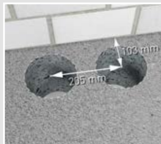
Die Deckenschott Systeme können in einem Abstand von 205 mm oder 125 mm auch als Gruppenanordnung montiert werden.
