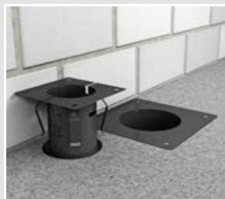
Einsetzen der Montagehülse von der Deckenoberseite.
