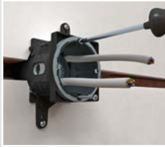
Leitungen in Dose einführen, Dose am Adapter festschrauben
