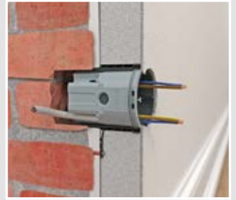
Signaldeckel entfernen und gewünschten Geräteeinsatz montieren
