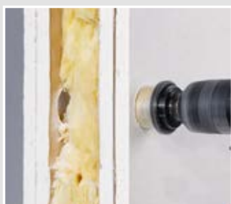
Installationsöffnung Ø 35 mm z. B. mit dem KAISER-Fräser Multi 4000 (1082-10) erstellen.
