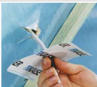
Manschette über die Leitung bzw. das Rohr schieben.
