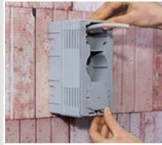
Den Kombinationseinsatz aufsetzen (Verschlussclip unten) und einrasten.
