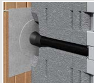
Für die luftdichte Installation die Rohr-Austrittsstelle mit einer geeigneten Luftdichtungsmanschette...
