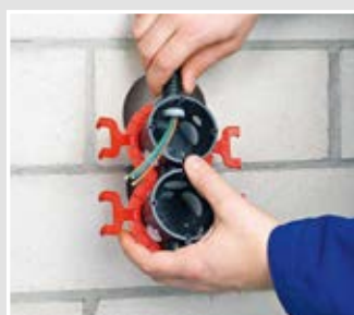
Einbauöffnung herstellen.
