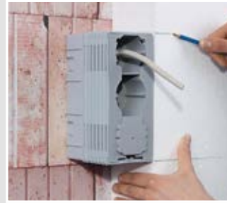
Nun kann die Dämmung angepasst und montiert werden.
