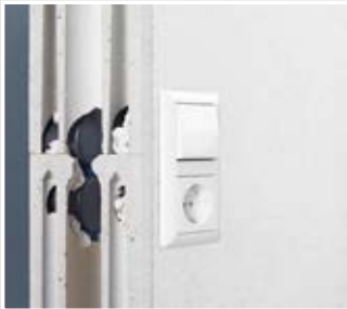
Einbaubeispiel einer Schalter-Steckdosenkombination
