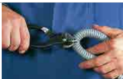
Schlauch knicken und Wendel mit der Zange durchtrennen Bend the conduit and cut through the helix
