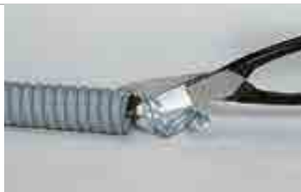
Mit Feinblechschere trennen, 1 bis 2 Schlauchgänge ausheben, quer zum Profil abschneiden, ausgehobene Gangenden beidrücken. Mit einer Blechschere die überstehenden Teile sauber abschneiden. Cut off with snips. Uncoil one or two segments and cut off. Press in the ends and snip off the protruding corners.
