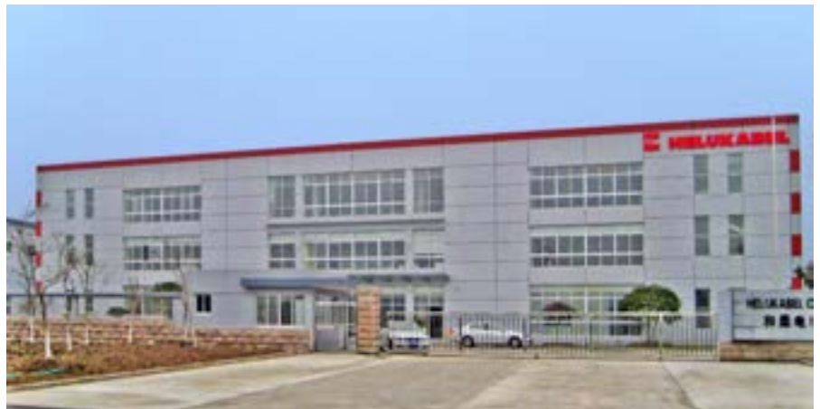
HELUKABEL® Produktion und Logistik-Zentrum in Taicang / China
