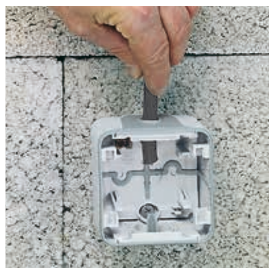
Kabel einführen
