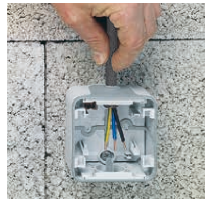
ZUM ERREICHEN DER SCHUTZART IP55 1) KABEL LEICHT ZURÜCKZIEHEN
