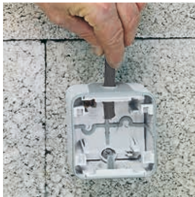
KABEL EINFÜHREN
