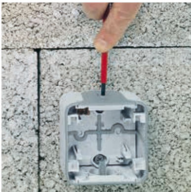
DURCHSTOßEN DER MEMBRANEINFÜHRUNG MITTELS SCHRAUBENDREHER
