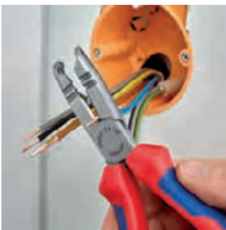
Schneiden beim Einkürzen von Einzelleitern
